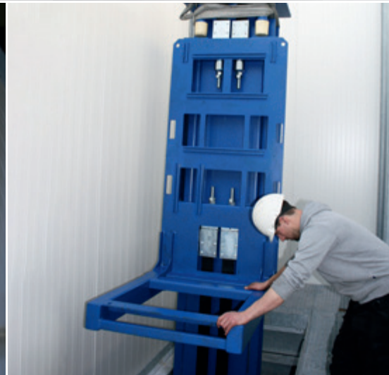
Millimeterarbeit bei der Einbringung der Senkrechtförderer über das Dach der Produktion
